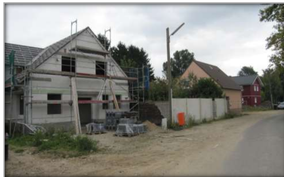
Seitenansicht des fertiggestellten Hauses entlang der Gronerstraße
